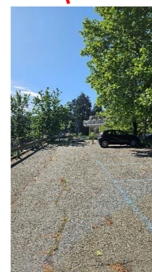
DISCESA PEDONALE DAL PARCHEGGIO A VIA JERVIS - IVREA
