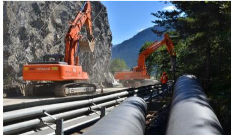
Lunghezza totale condotte: **67 Km**, diametro  $\varnothing$  800-700-600 mm in ghisa sferoidale
