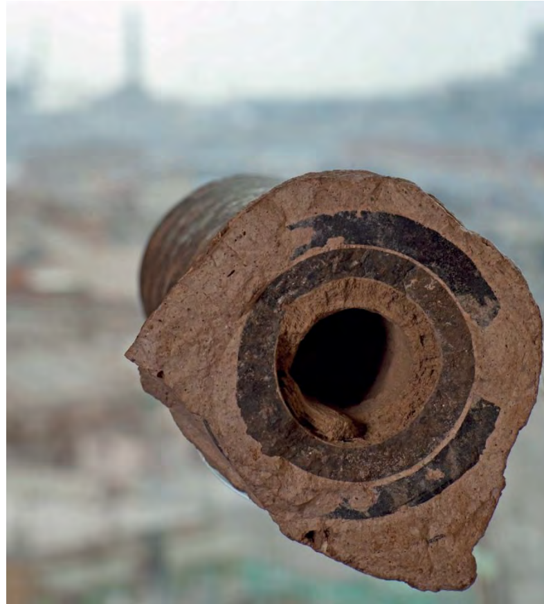
Frammento di tubo del primo acquedotto di New York Croton Reservoir
