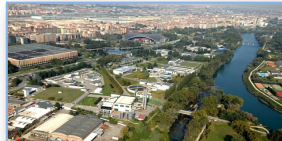
Potenziamento Impianto Po
