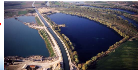
Ampliamento bacini di lagunaggio
